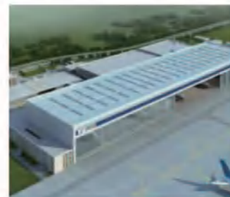
北京新机场东航基地项目 (抗震支架)
