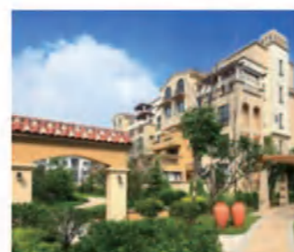
沈阳万科怡园养老中心 (和平店) (抗震支架)
