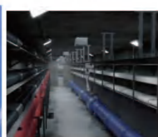
济南地下管廊 (成品支架和托臂)
