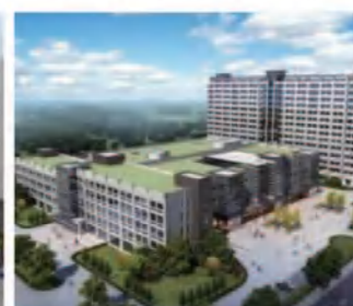
北京通州行政副中心部分办公楼 (抗震支架)
