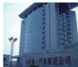
长春一汽 (喷漆车间) (抗震支架)
